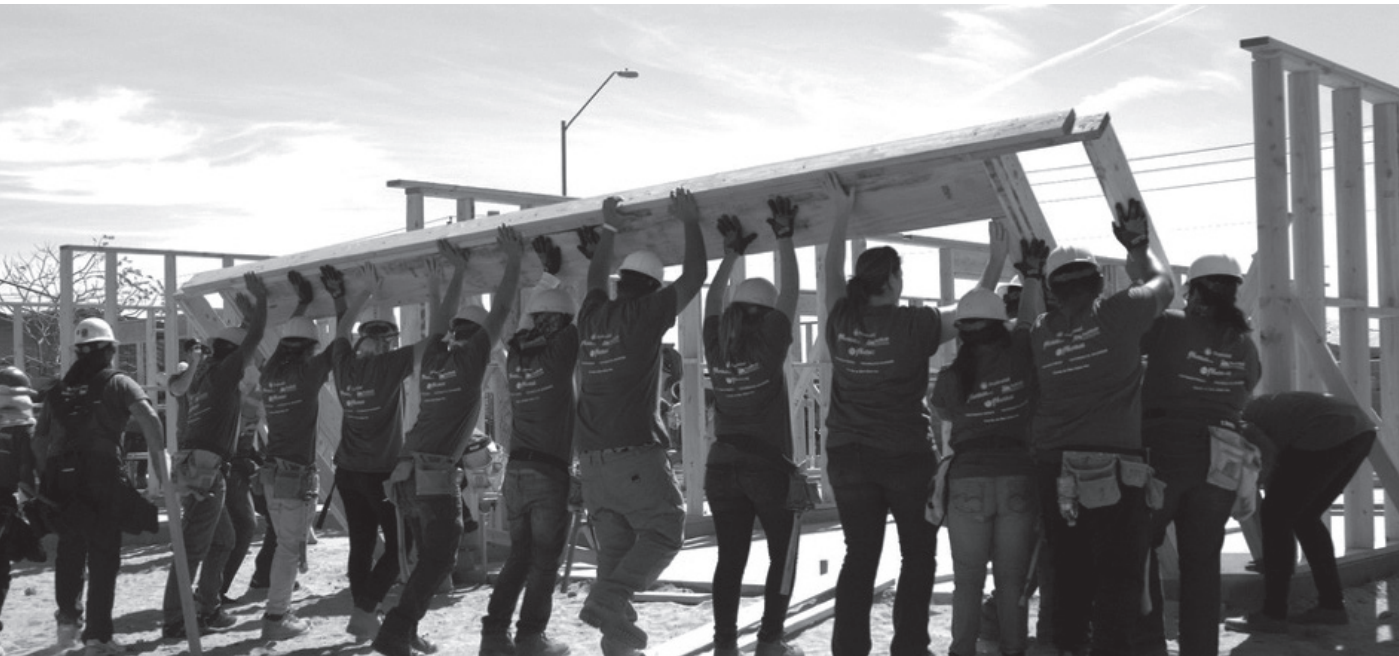
Estudiantes de YouthBuild de México, El Salvador, y los Estados Unidos trabajando juntos en la construcción de dos viviendas accesibles (bajo ingreso) en San Luis, Arizona, EE. UU., como parte del primer evento transfronterizo el día del servicio global YouthBuild. Marzo 2016.
